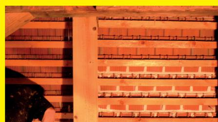
Durch den Auftrag von **ROBA-flex®** nur im waagerechten und senkrechten Fugenbereich, bleibt die Diffusionsfähigkeit der übrigen Dachfläche erhalten.
